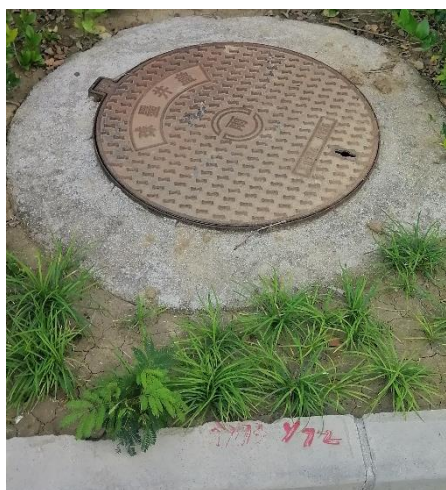
项目区排水系统
