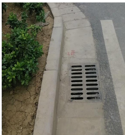
项目区排水系统
